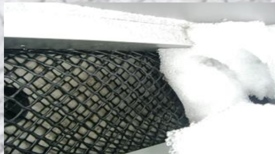
屋上外観（ダクト工事中）
