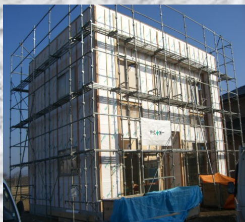
建築中の現場 糠野目地区
